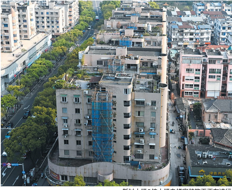
新村大楼5栋大楼电梯安装施工正在进行
